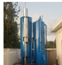
Hệ Lọc nổi - Xiphong 10m 3 /h (Trạm CN xã Ia Me, Ia Tor - Chư Prông- Gia Lai)
